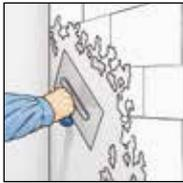
**1.** Alte Tapeten und Anstriche entfernen. Raue Untergründe mit gipshaltigen Spachtelmassen glätten. Stark saugende Untergründe mit lösungsmittelfreien Grundierungen grundieren.
